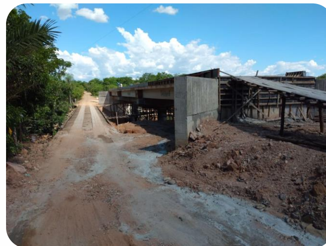
Novidade da safra 2020-2021 - Mapeamento de pontes
